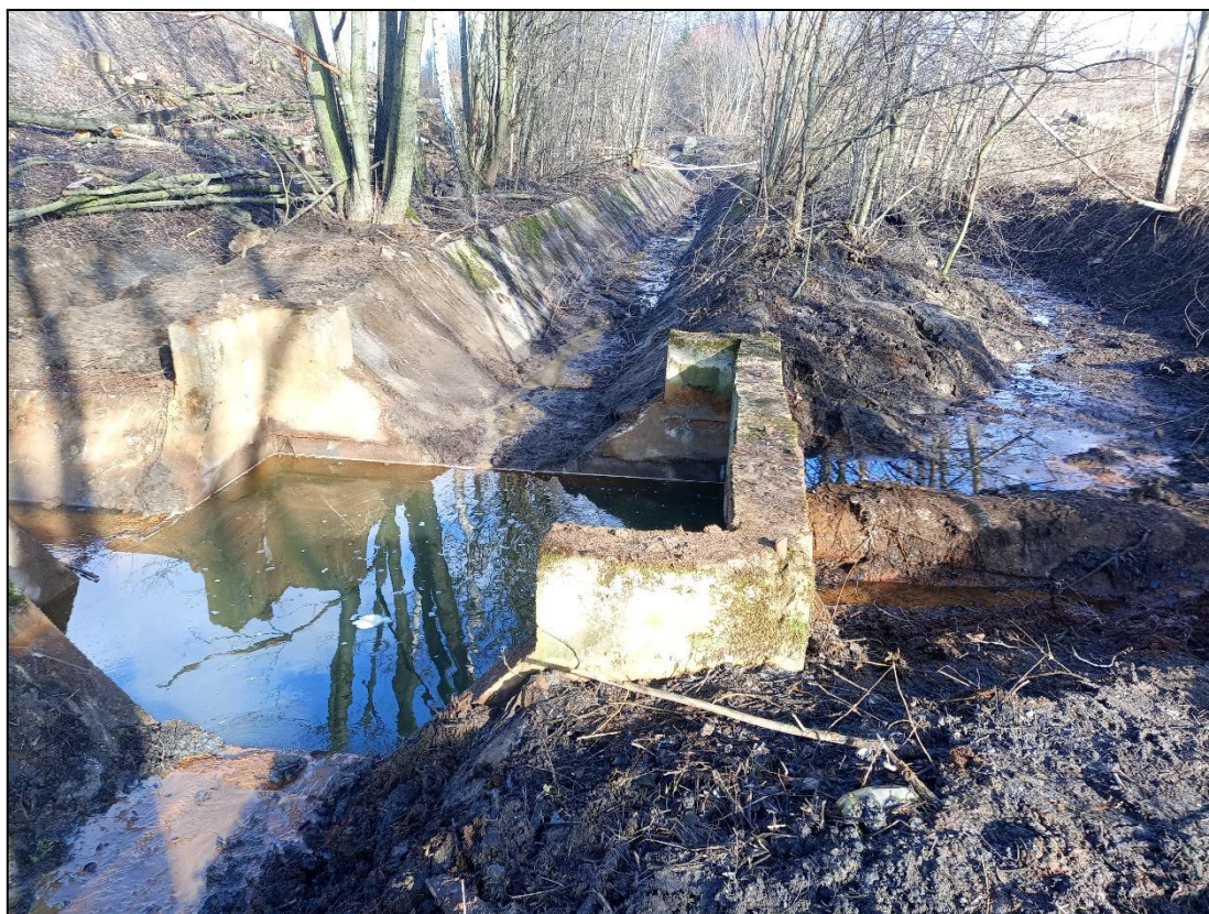
Obr. č. 15 – Vyčištěný odvodňovací systém vpravo, km 186,980 (03/2022)
