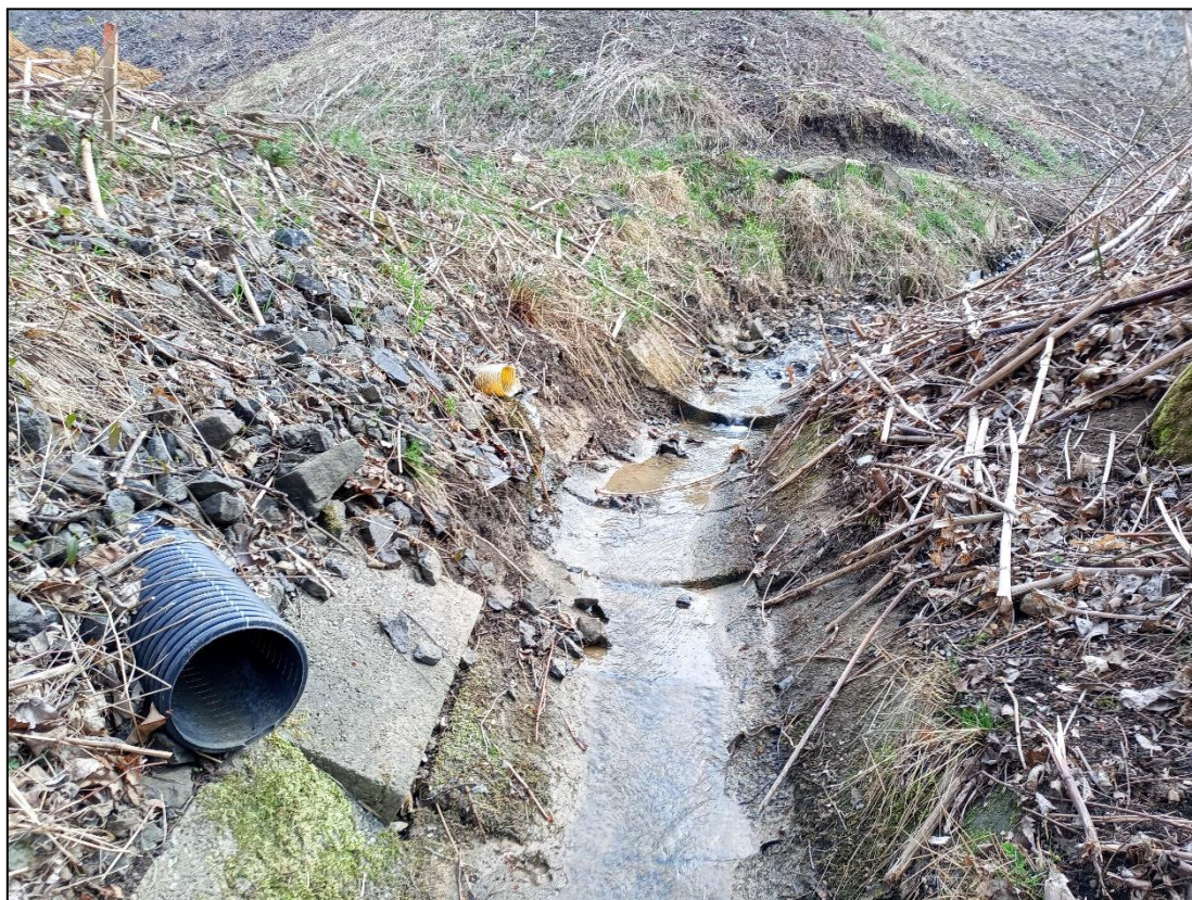
Obr. č. 20 – Vyústění patního drénu v km cca 186,700 vlevo.
