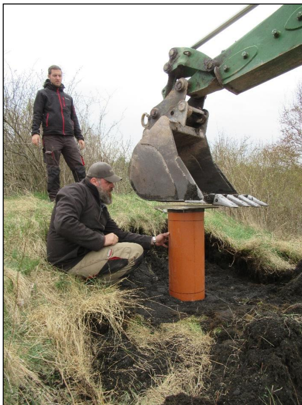
Obr. č. 23 – Odběr velkorozměrových vzorků, deponie v km 186,600 vpravo
