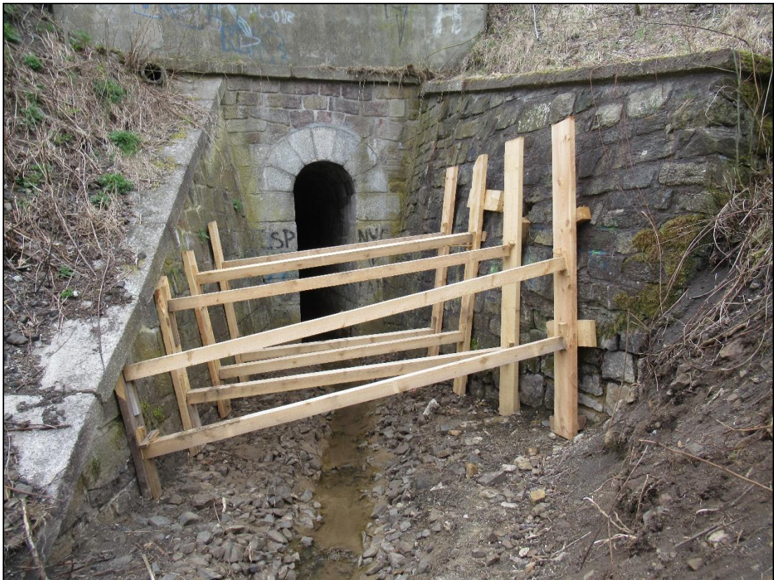
Obr. č. 26 – Sanované čelo propustku v km 186,696 vlevo
