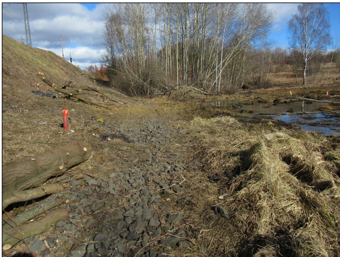
Obr. č. 17 – Odvodňovací drén u paty náspu vpravo, km 186,720
