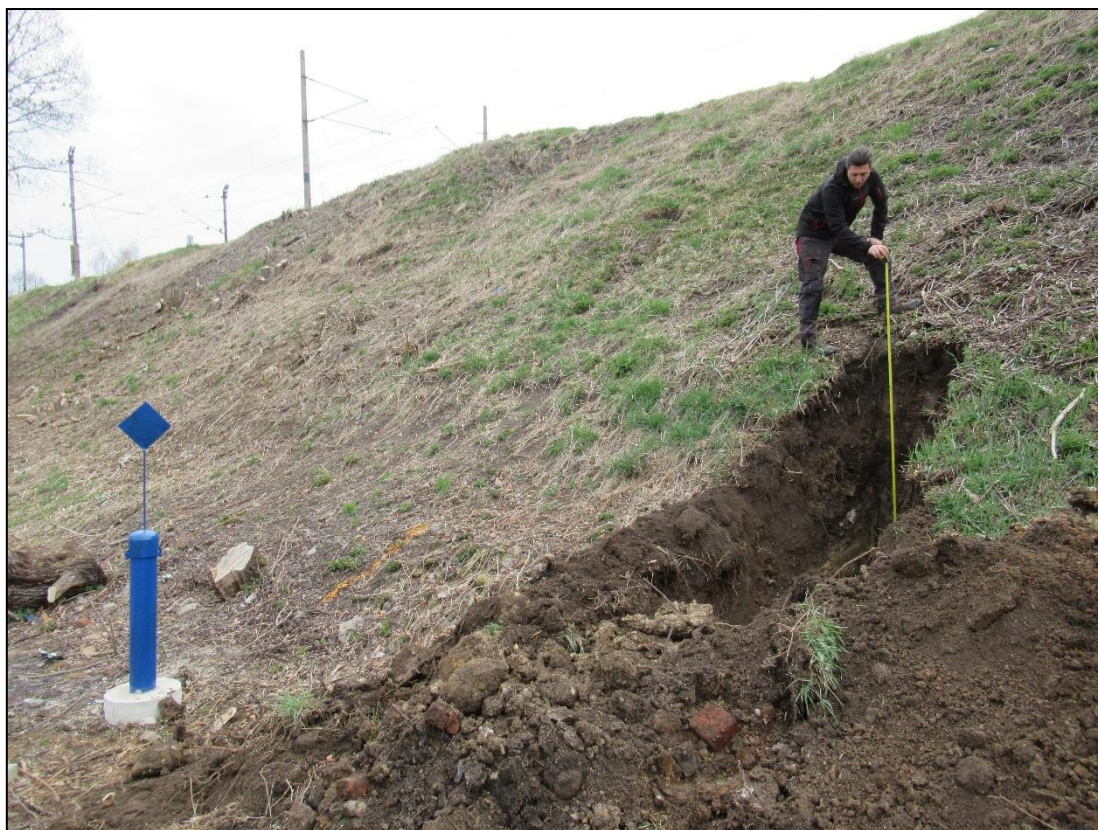
Obr. č. 21 - Vrt JH04 a kopaná sonda u paty náspu vpravo v km 186,855
