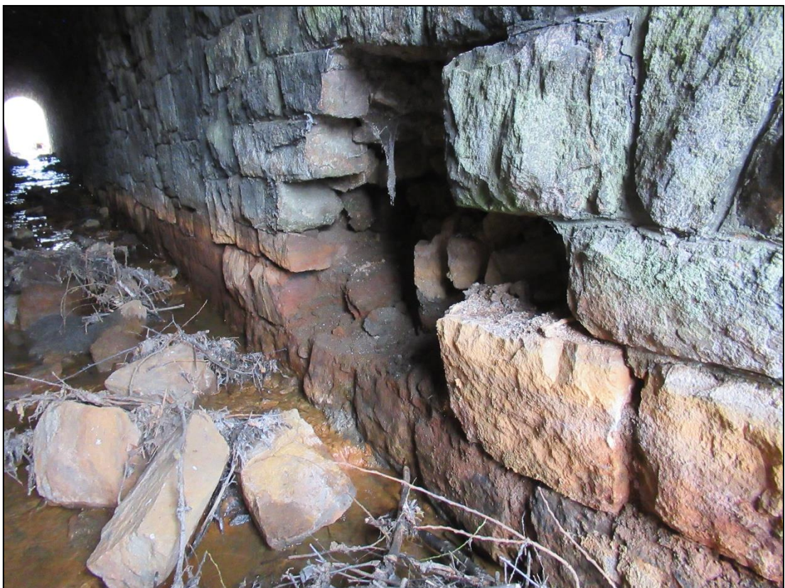
Obr. č. 28 – Porušení zdiva propustku v km 186,982
