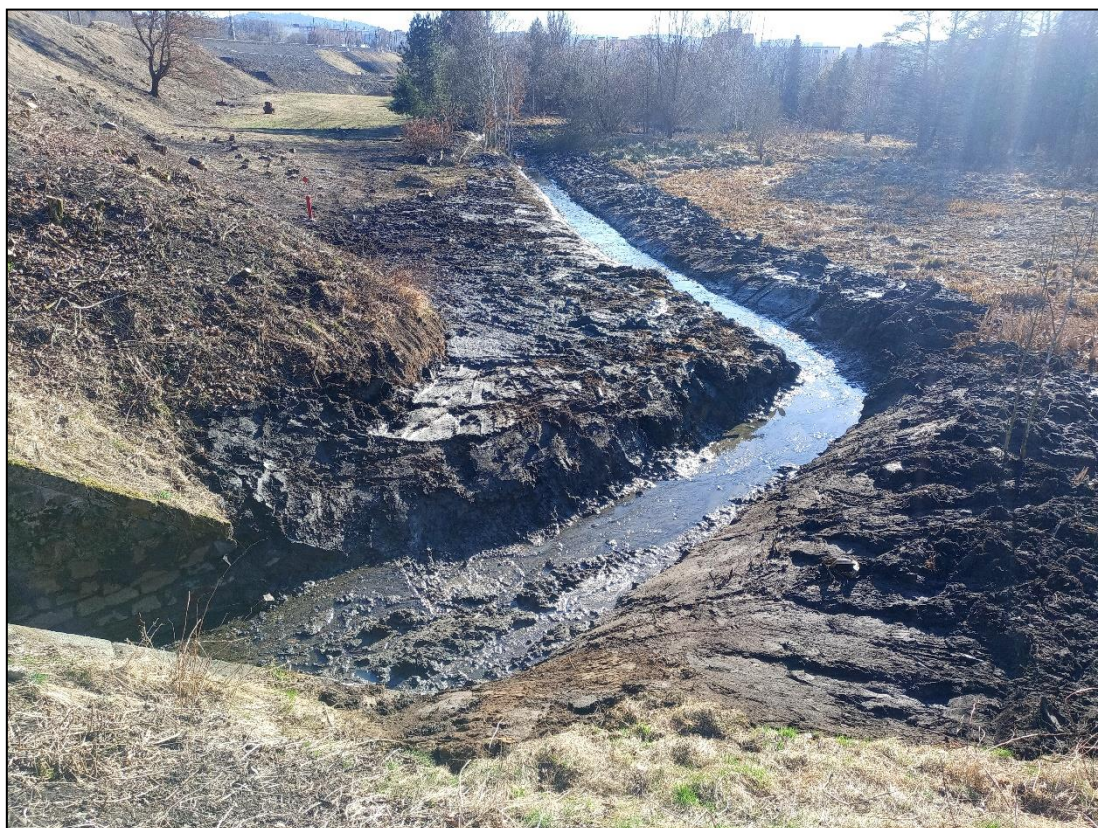
Obr. č. 16 – Vyčištěný odvodňovací systém vlevo, km 186,980 (03/2022)
